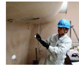
吸込み口の測定
