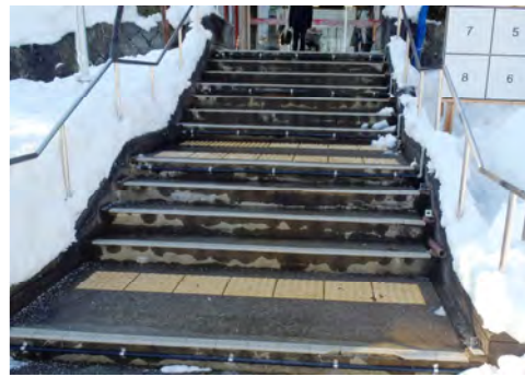
正面入口階段の消雪
