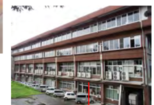
耐震化工事による室外機再取付
